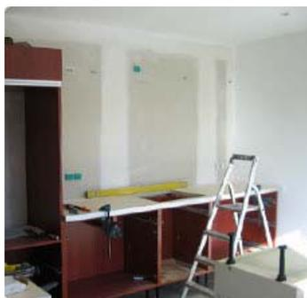
Les meubles hauts sont généralement montés aux murs sur des pattes d'accrochage à griffes ce qui permet leur fixation rapide et précise, et réserve un démontage possible dans de bonnes conditions.
