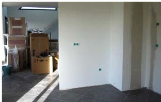
Durant cette phase de préparation, les installations de plomberie et d'électricité seront vérifiées et établies aux normes, par les artisans aux cotes exactes de la cuisine, et selon les plans d'implantation détaillés. Le chantier sera ainsi prêt pour effectuer la pose de la cuisine.
