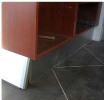
Pour permettre le basculement de la porte du lave vaisselle à son ouverture, le poseur pratiquera à cet endroit, une découpe de environ 15 mm de haut sur la largeur de la machine. Des pièces spécifiques seront souvent posées aux angles pour assurer la finition et la pérennité des socles.
